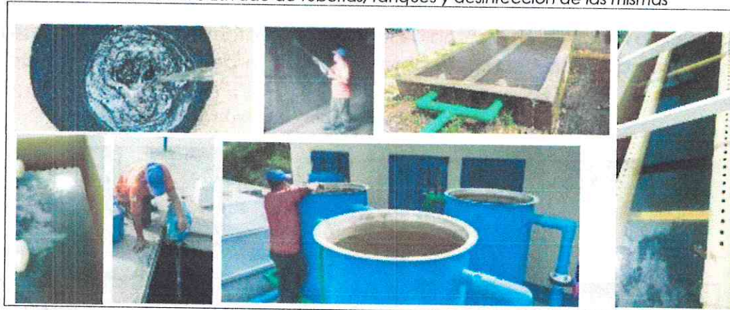
Ilustración 5 Lavado de tuberías, tanques y desinfección de las mismas
