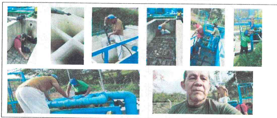
Ilustración 4 Lavado de la planta de tratamiento
